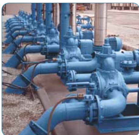
Насос серии HXL6 с электродвигателем
